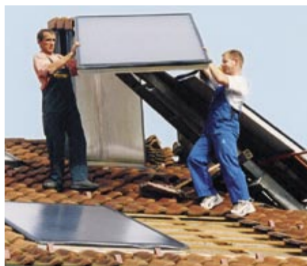
Die Kollektoren werden in die vorbereitete Dachöffnung gelegt und befestigt.
