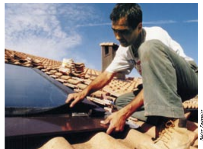
Das Kollektorfeld wird mit Kupferblechen eingefasst und die Dachöffnung wieder mit Ziegeln verschlossen.
