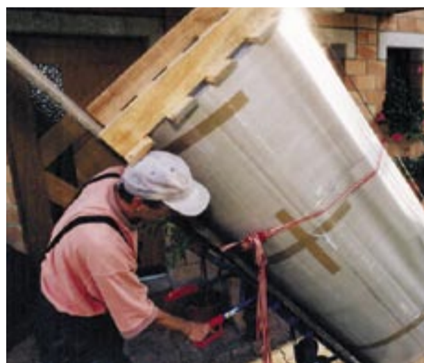
Einfach und schnell montiert: Der Warmwasserspeicher wird geliefert.
